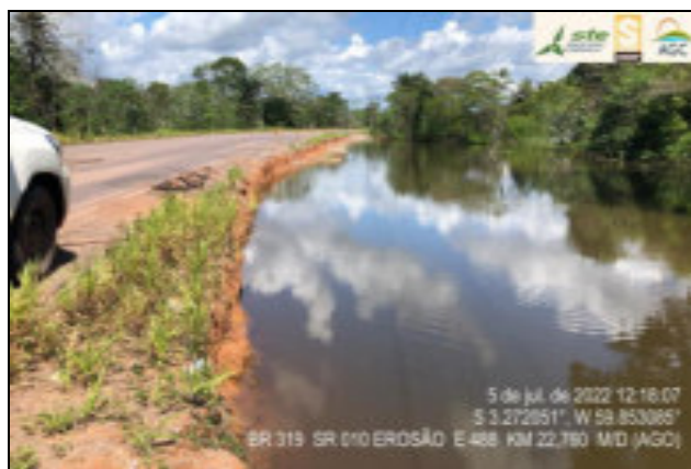
5 de jul. de 2022 12:16:07 S 3.272051°, W 59.853086° BR 319 SR 010 EROSÃO E 488 KM 22,760 MID (AGO) BR-319/AM EROSÃO LD KM: 22,700 ESTACA: 485
