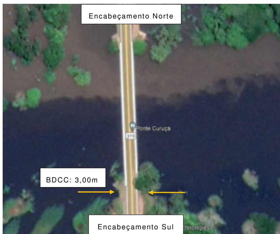
FOTO 1: LOCALIZAÇÃO DA PONTE
