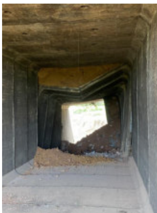
FOTO 6: BDCC MONTANTE LADO ESQUERDO COM ESMAGAMENTO DAS ADUELAS
