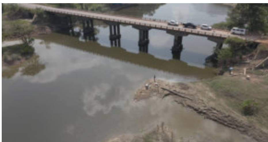
FOTO 3: IMAGEM AÉREA COM VISÃO GERAL DA PONTE SOBRE O RIO CURUÇÁ. PARTE SUPERIOR DA FOTO: JUSANTE, PARTE INFERIOR DA FOTO: MONTANTE.
