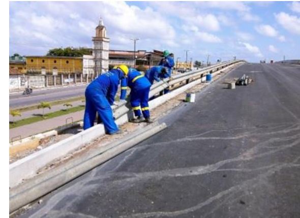
Viaduto da Casa da Moeda (BR-101/RJ) Liberação do Tréfygo em mar/19
